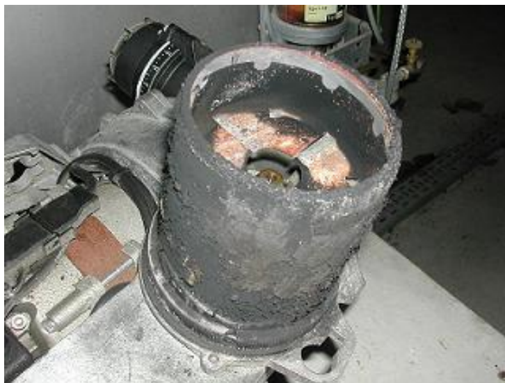
Рисунок 12. Пример грязной и чистой горелки
