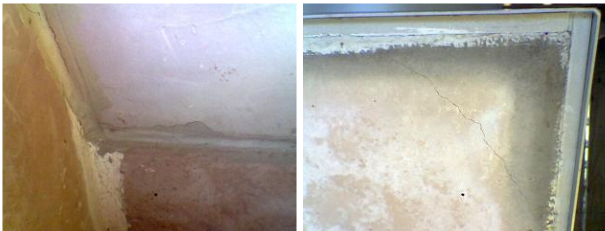
Рисунок 10. Примеры нормального допустимого теплового растрескивания.
