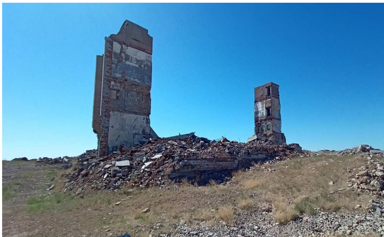
Рисунок 2.22 – Остатки (подъезды) вспомогательного здания производственного назначения
