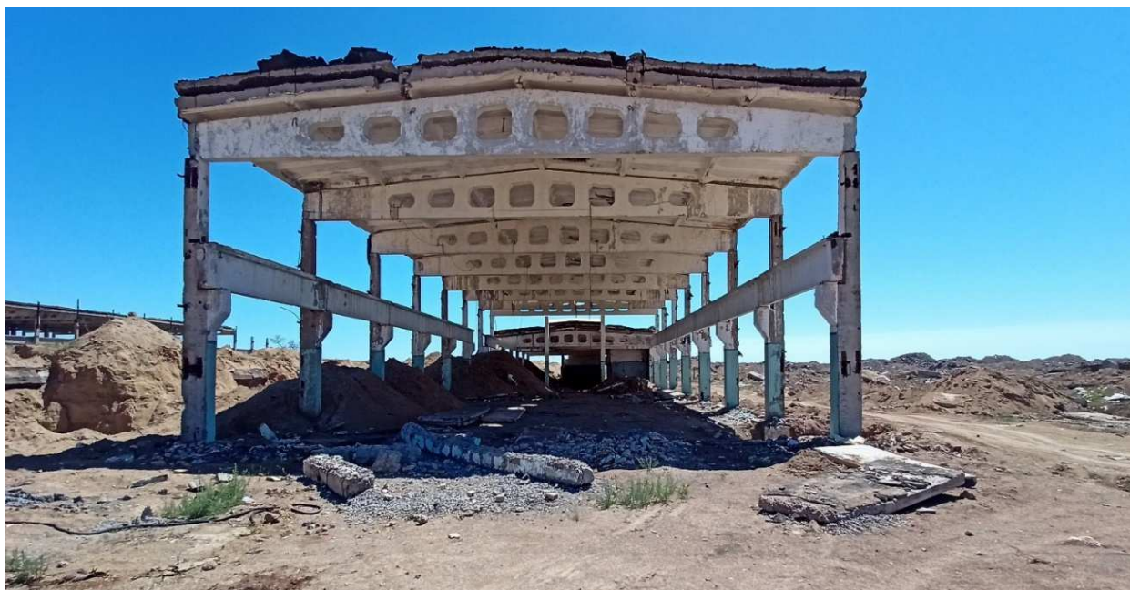
Рисунок 2.25 – Каркас здания цеха готовой продукции
