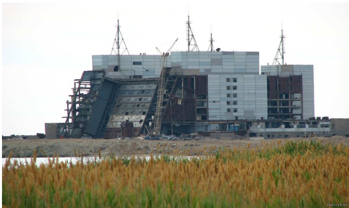
Рисунок 2.20 – Здание передающей антенны «Дарьял-У» в процессе несанкционированного монтажа (предположительно 2008-2009 гг)
