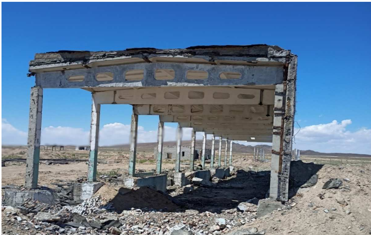
Рисунок 2.24 – Каркас здания водоподающей запорно-распределительной арматуры системы водоохлаждения РЛС
