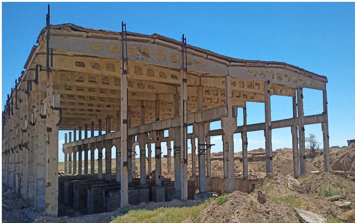
Рисунок 2.26 – Каркас здания холодильного цеха
