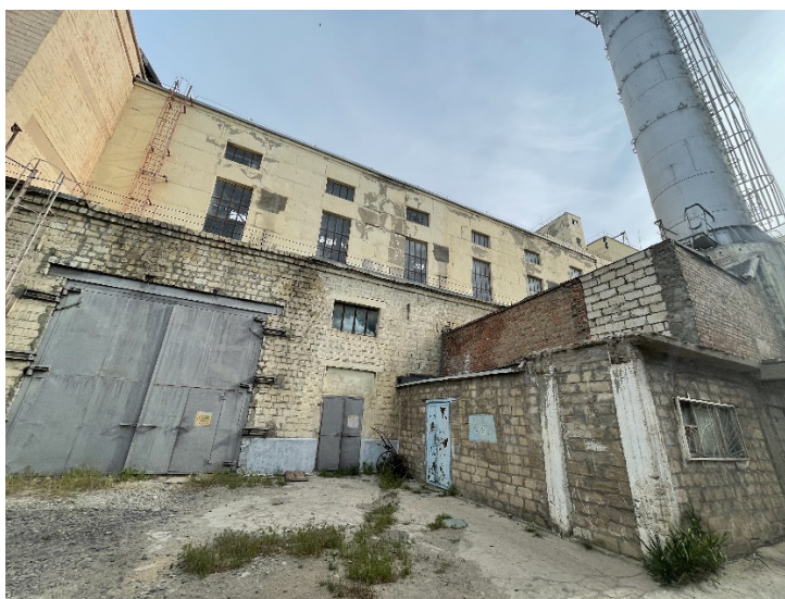
Рисунок 2.1.1. Существующее здание ТЭЦ-1 ТОО МАЭК-Казатомпром для установки водогрейных котлов
