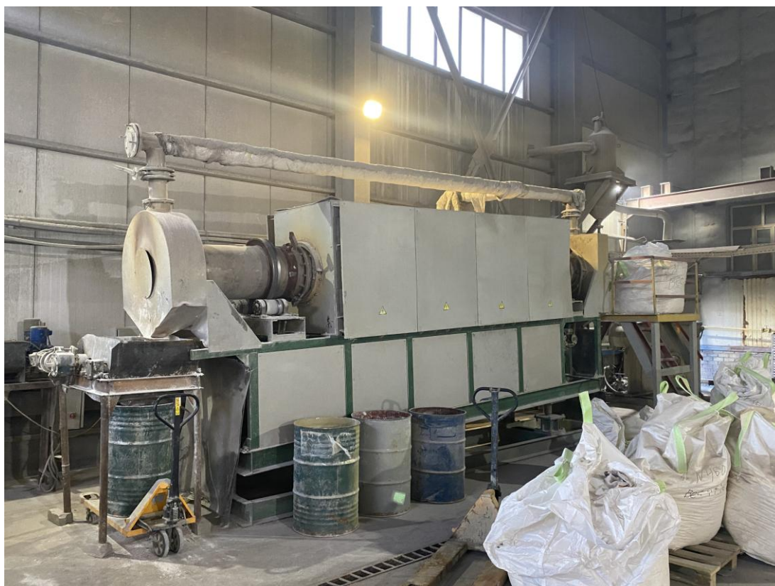
Строительно-монтажные работы по установке и запуску в работу сушильного барабана ПБ-500.
