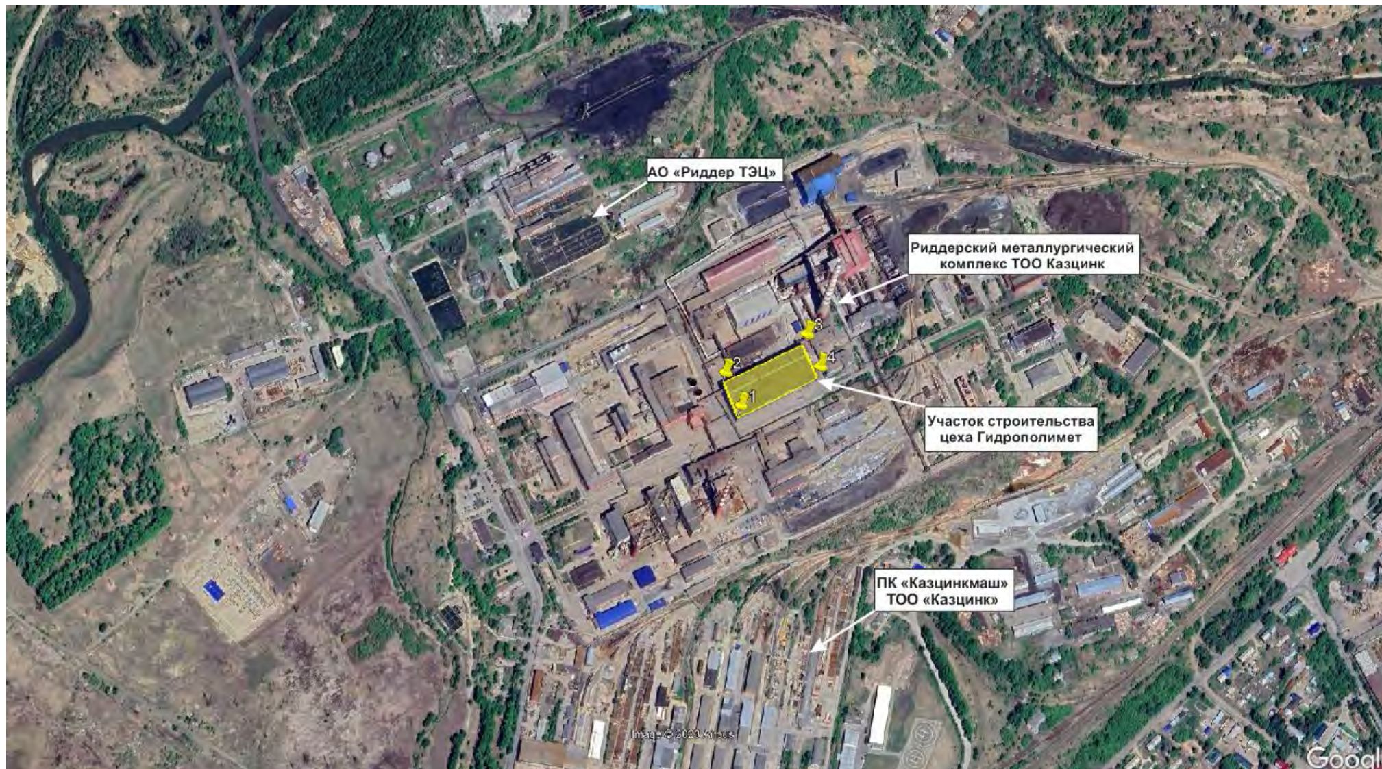
Рисунок 1. Месторасположения участка строительства цеха Гидрополимет.
