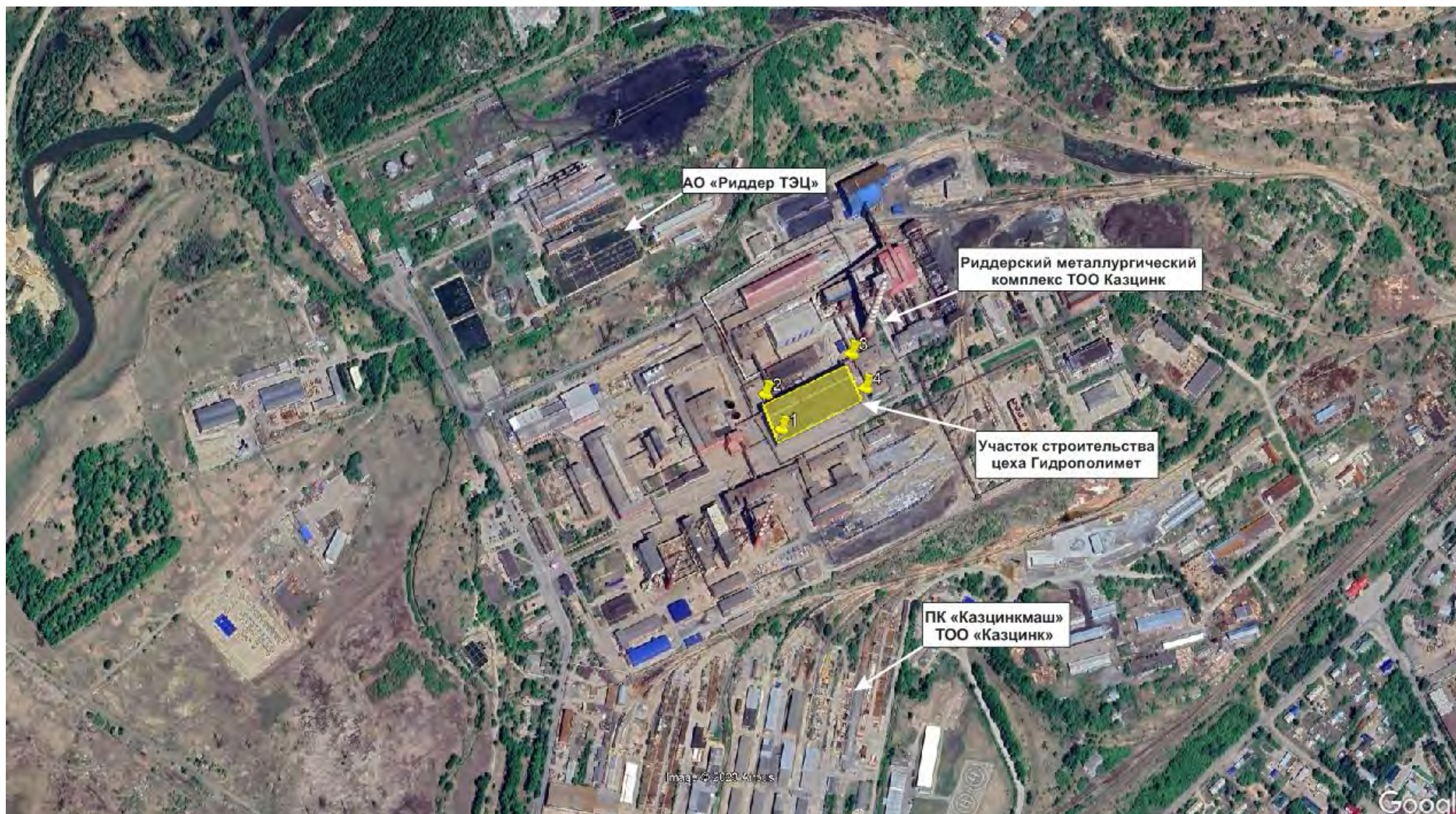
Рисунок 1. Месторасположения участка строительства цеха Гидрополимет.
