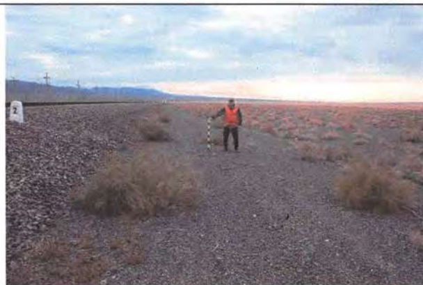
Фото 21. ПК 2618+99.60 перегона разъезд 16-станция Жаланашколь и перегона станция Жаланашколь-разъезд 19 ПК2619+20. Южная половина участка. Западная сторона. Вид на юго-восток.
