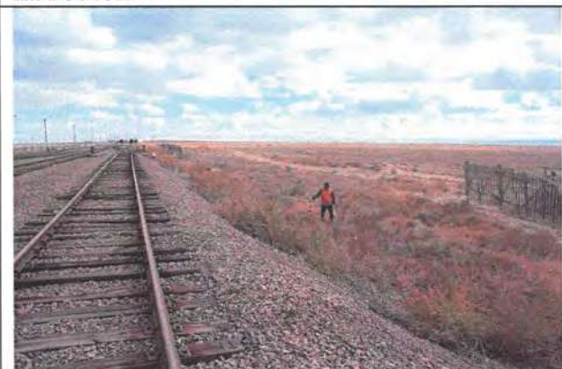
Фото 12. ПК 15602+56 перегона разъезд 5–станция Жаксыбулак и перегона станция Актогай-Восточная–станция Сарыкум ПК 171+71. Промежуточное фото участка. Юго-восточная половина. Южная сторона. Вид на юго-восток.
