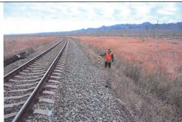
Фото 17. ПК 2618+99.60 перегона разъезд 16–станция Жаланашколь и перегона станция Жаланашколь–разъезд 19 ПК2619+20. Южный край участка. Восточная сторона. Вид на северо-запад.
