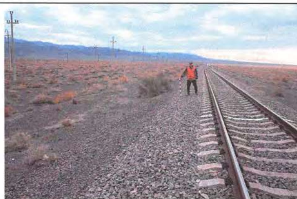
Фото 22. ПК 2618+99.60 перегона разъезд 16-станция Жаланашколь и перегона станция Жаланашколь-разъезд 19 ПК2619+20. Южная половина участка. Восточная сторона. Вид на юго-восток.
