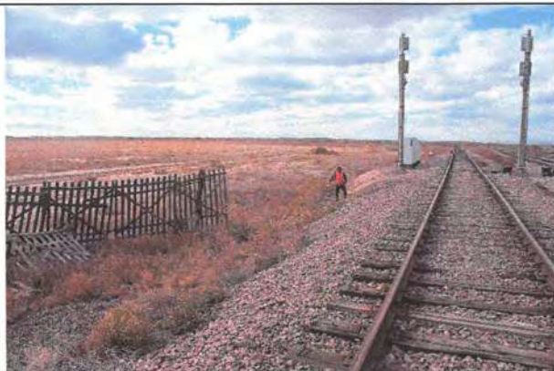
Фото 13. ПК 15602+56 перегона разъезд 5–станция Жаксыбулак и перегона станция Актогай-Восточная–станция Сарыкум ПК 171+71. Промежуточное фото участка. Юго-восточная половина. Южная сторона. Вид на северо-запад.
