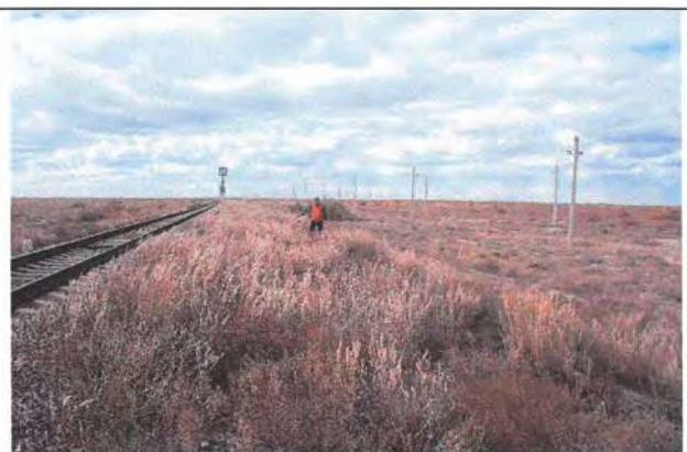
Фото 8. ПК 15602+56 перегона разъезд 5–станция Жаксыбулак и перегона станция Актогай-Восточная–станция Сарыкум ПК 171+71. Юго-восточный край участка. Северная сторона. Вид на северо-запад.
