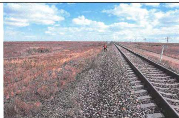
Фото 6. ПК 15602+56 перегона разъезд 5–станция Жаксыбулак и перегона станция Актогай-Восточная–станция Сарыкум ПК 171+71. Западный край участка. Северная сторона. Вид на восток.
