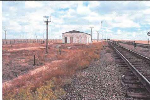
Фото 15. ПК 15602+56 перегона разъезд 5–станция Жаксыбулак и перегона станция Актогай-Восточная–станция Сарыкум ПК 171+71. Промежуточное фото участка. Юго-восточная половина. Северная сторона. Вид на юго-восток.
