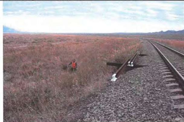
Фото 16. ПК 2618+99.60 перегона разъезд 16–станция Жаланашколь и перегона станция Жаланашколь–разъезд 19 ПК2619+20. Южный край участка. Западная сторона. Вид на северо-запад.
