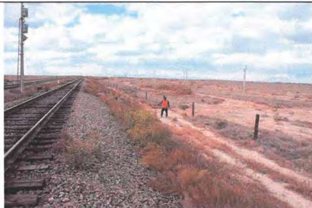
Фото 14. ПК 15602+56 перегона разъезд 5–станция Жаксыбулак и перегона станция Актогай-Восточная–станция Сарыкум ПК 171+71. Промежуточное фото участка. Юго-восточная половина. Северная сторона. Вид на северо-запад.
