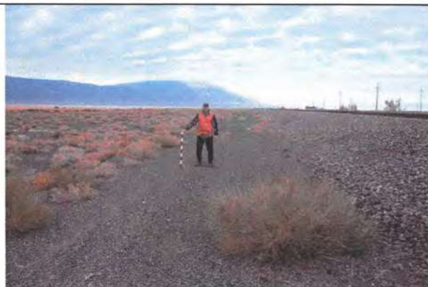
Фото 20. ПК 2618+99.60 перегона разъезд 16-станция Жаланашколь и перегона станция Жаланашколь-разъезд 19 ПК2619+20. Южная половина участка. Западная сторона. Вид на северо-запад.
