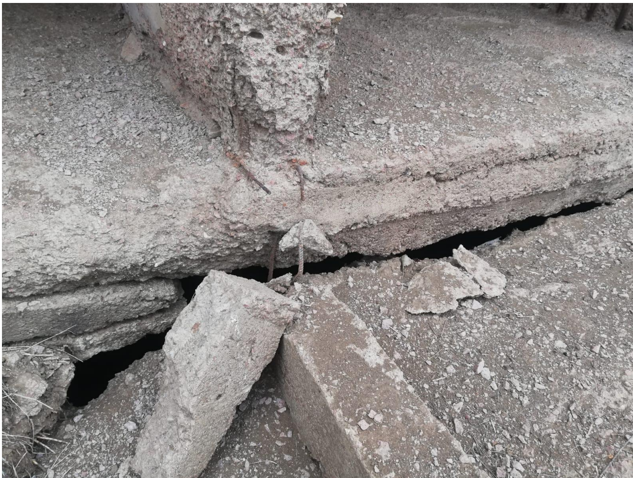
Рис. 20 – Разломы на стыках
