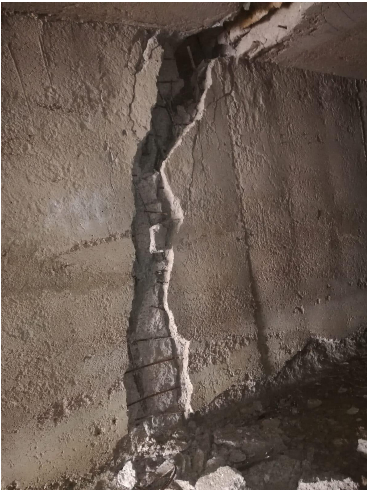
Рис. 15 – Разлом в стене
