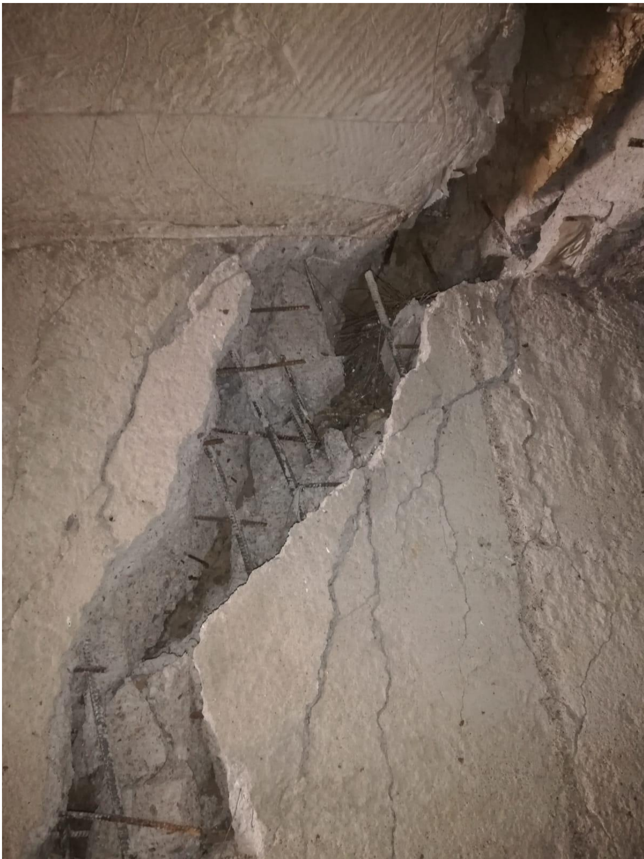
Рис. 17 – Разлом в стене
