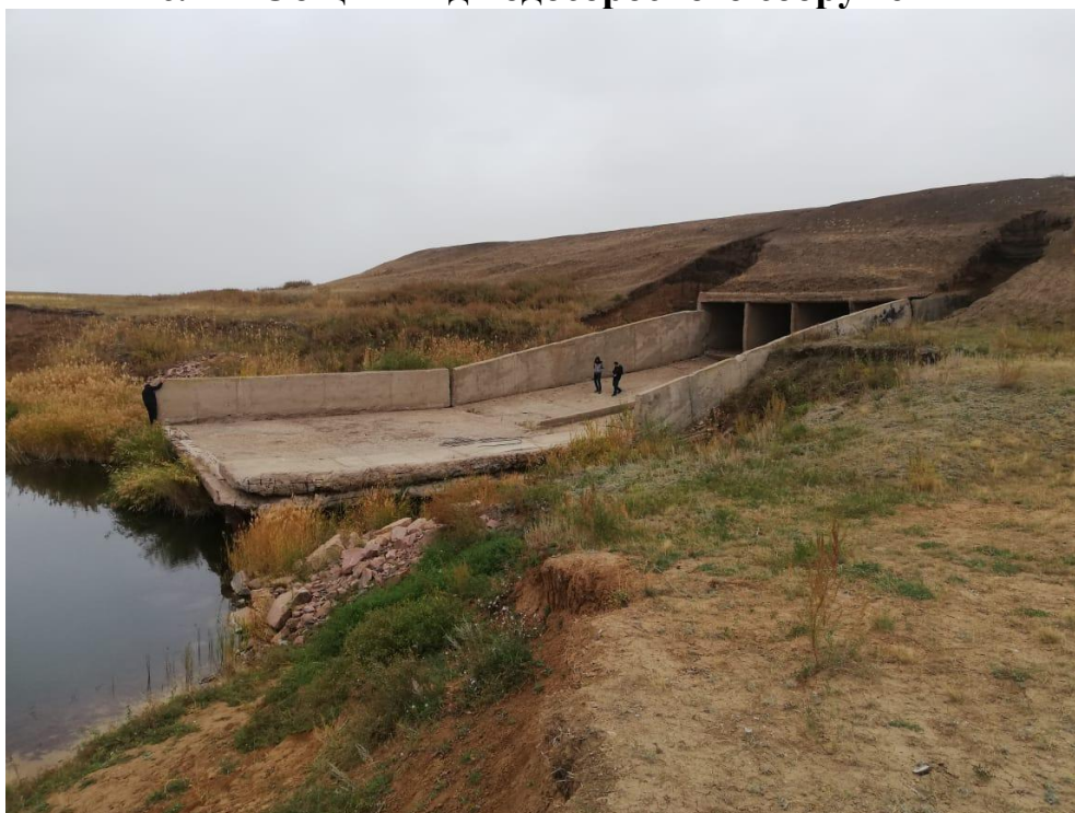
Рис. 2 – ковшовый водосброс
