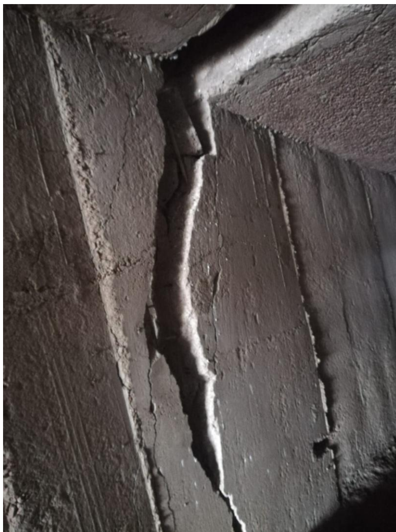
Рис. 7 – Разлом в стене
