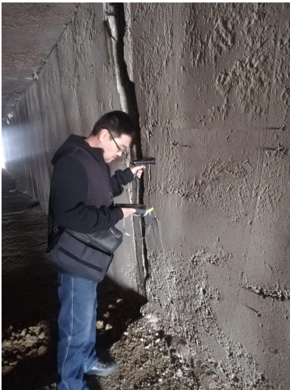
Рис. 22 – Определение прочности бетона
