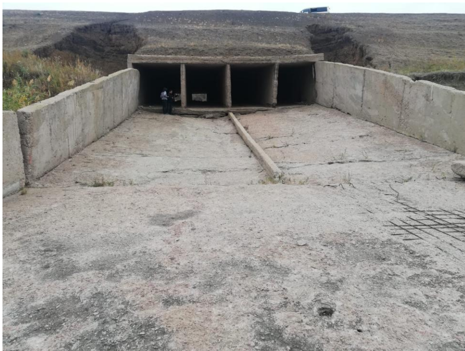
Рис. 1 – Общий вид водосбросного сооружения
