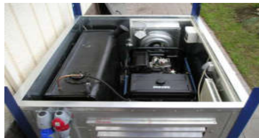
Рис. 8 Дизельный генератор SDMO X 180/4DE мощностью 5 кВт в миниконтейнере
