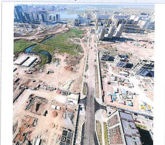
Состояние строительства объекта
