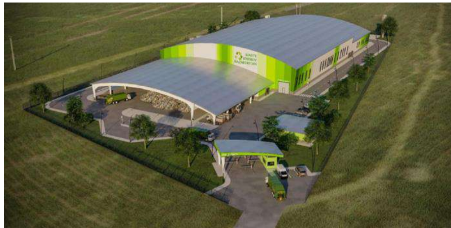
Рисунок 2 - Перерабатывающий завод полной утилизации ТБО
