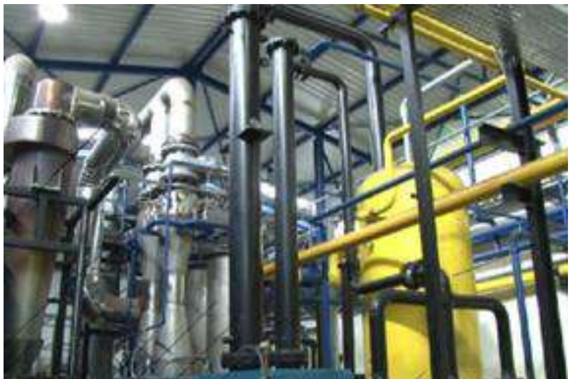
Рисунок 26 Блок получения сжатого газа
