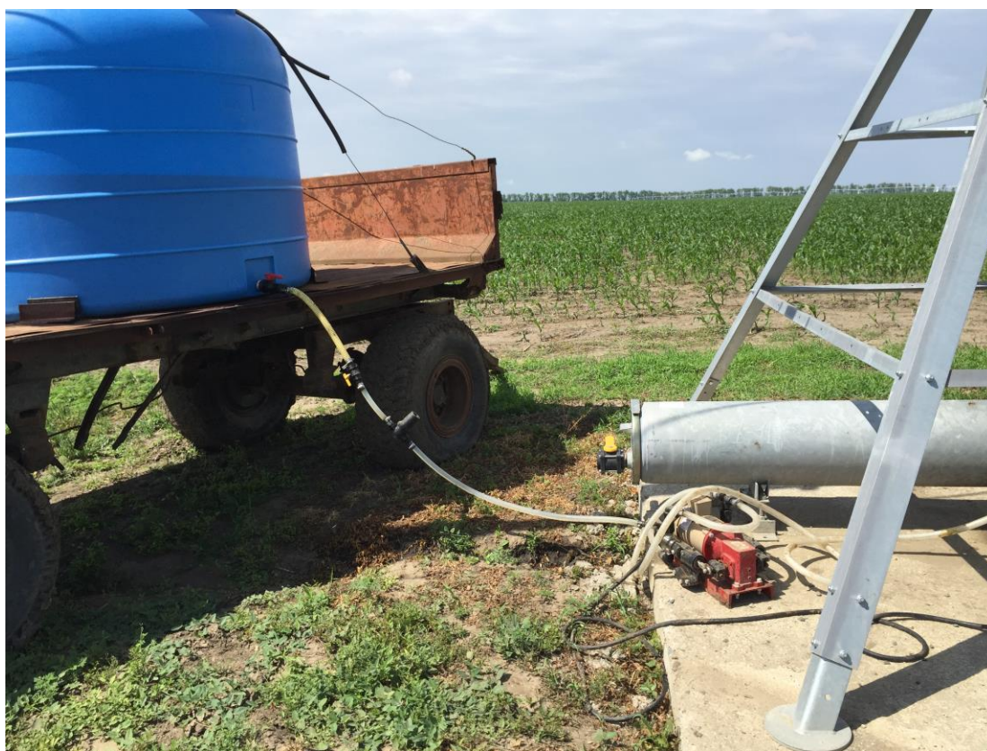
Рисунок 11 – Установка переносного дозатора
