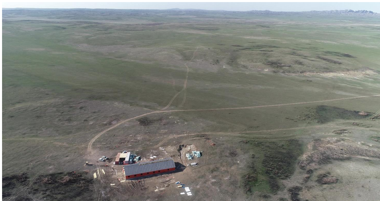
Фото 6. Общий вид на земельный участок с юга. На переднем плане строящееся здание рабочего городка.
