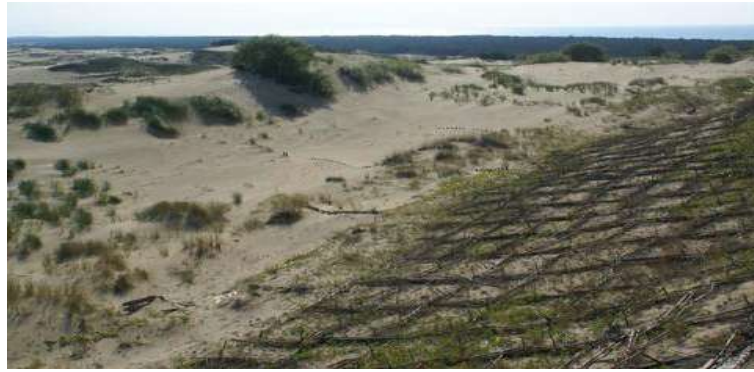
Рис. 1.2.9 – Закрепление подвижных песков
