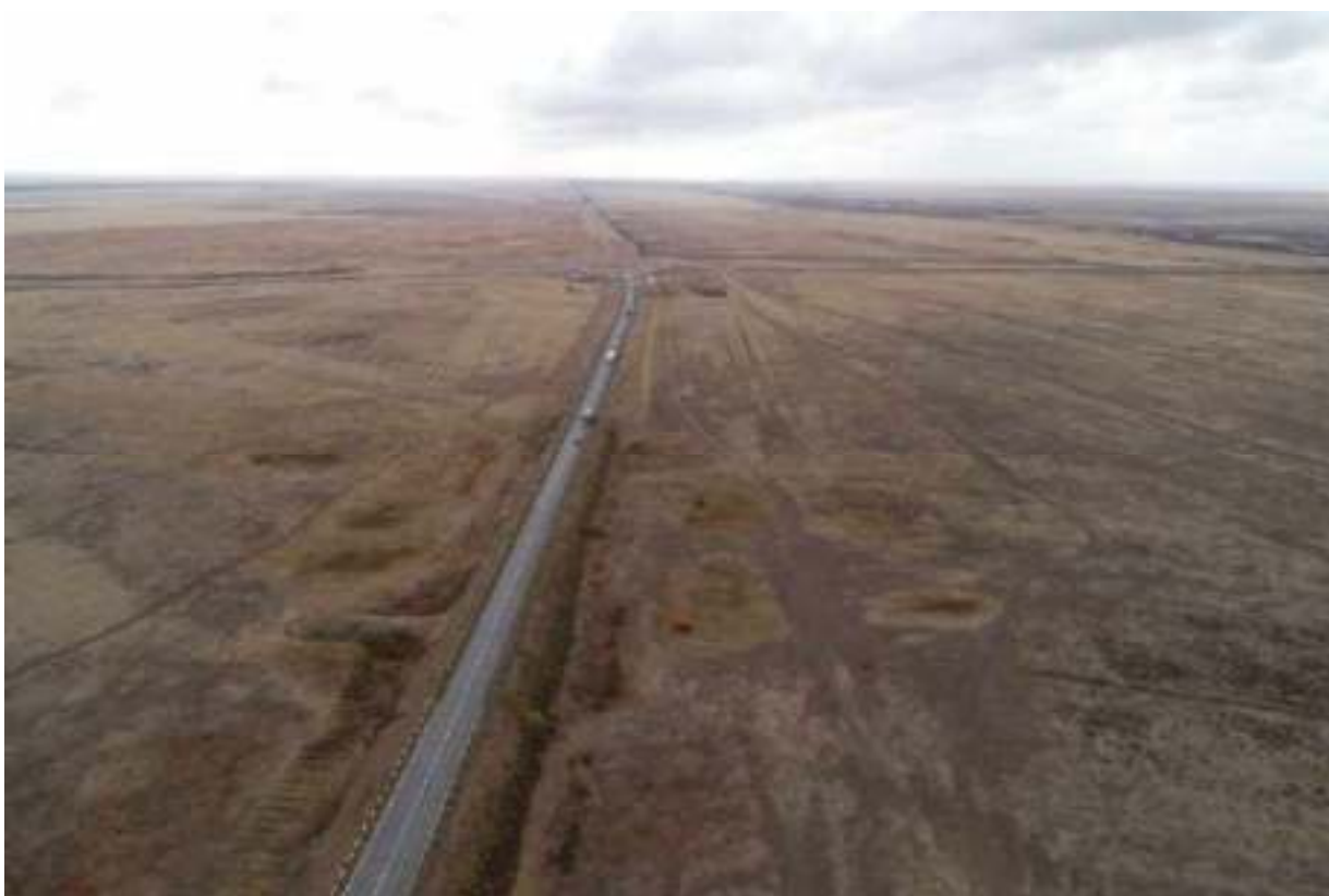
Фото 4. Участок Автодороги в районе моста через р. Ишим.
