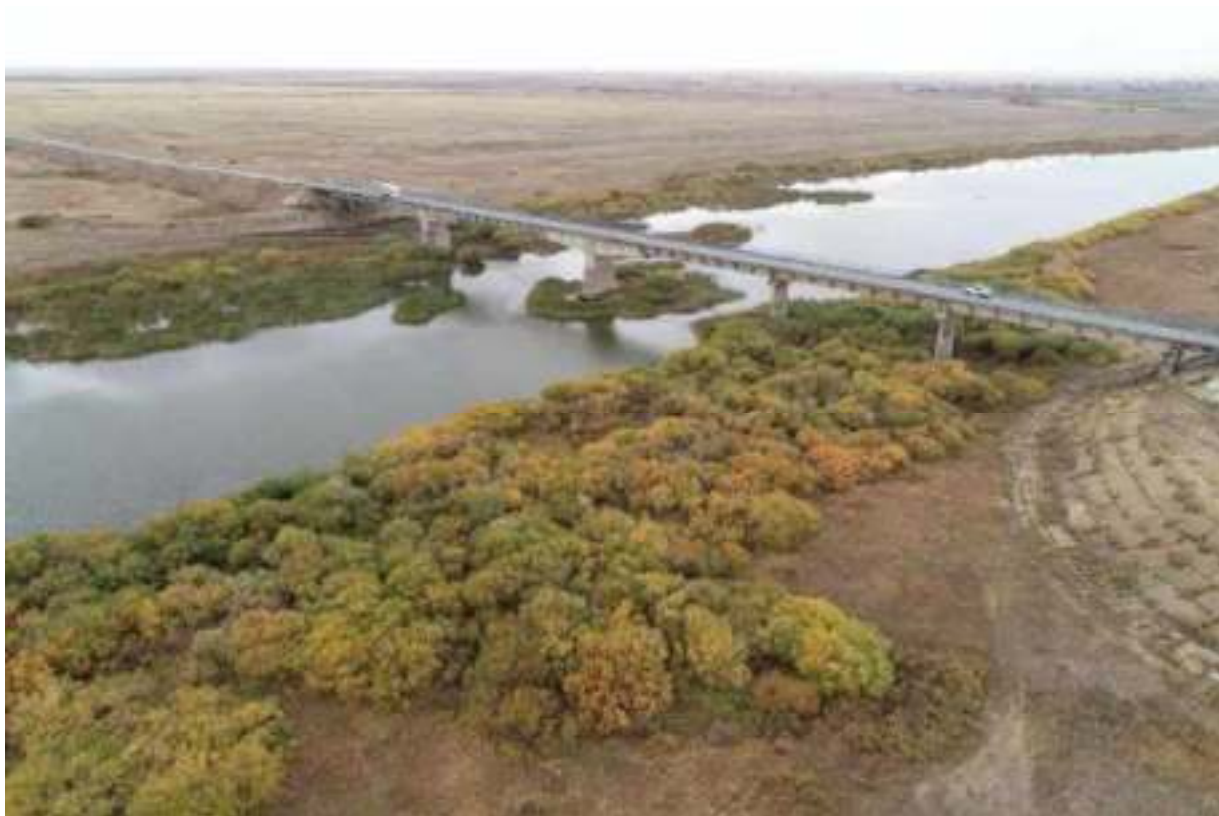
Фото 3. Мост через р. Ишим.
