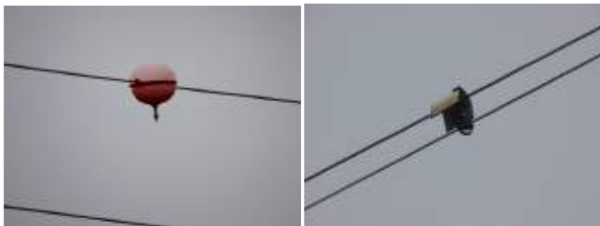
Рисунок - Пример маркирующих устройств, предотвращающих столкновение птиц об провода.
