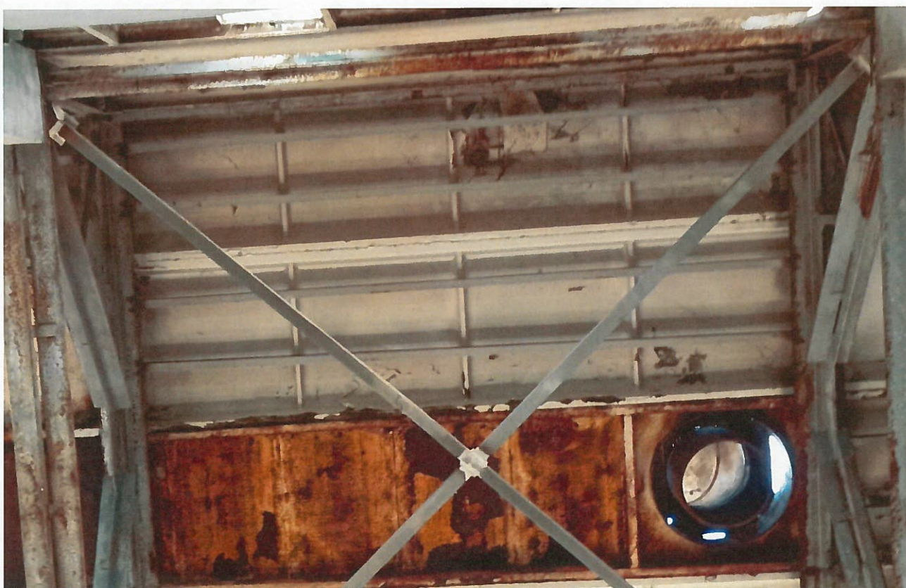
Фото.5.7.1. Усиление плит покрытия швеллерами
