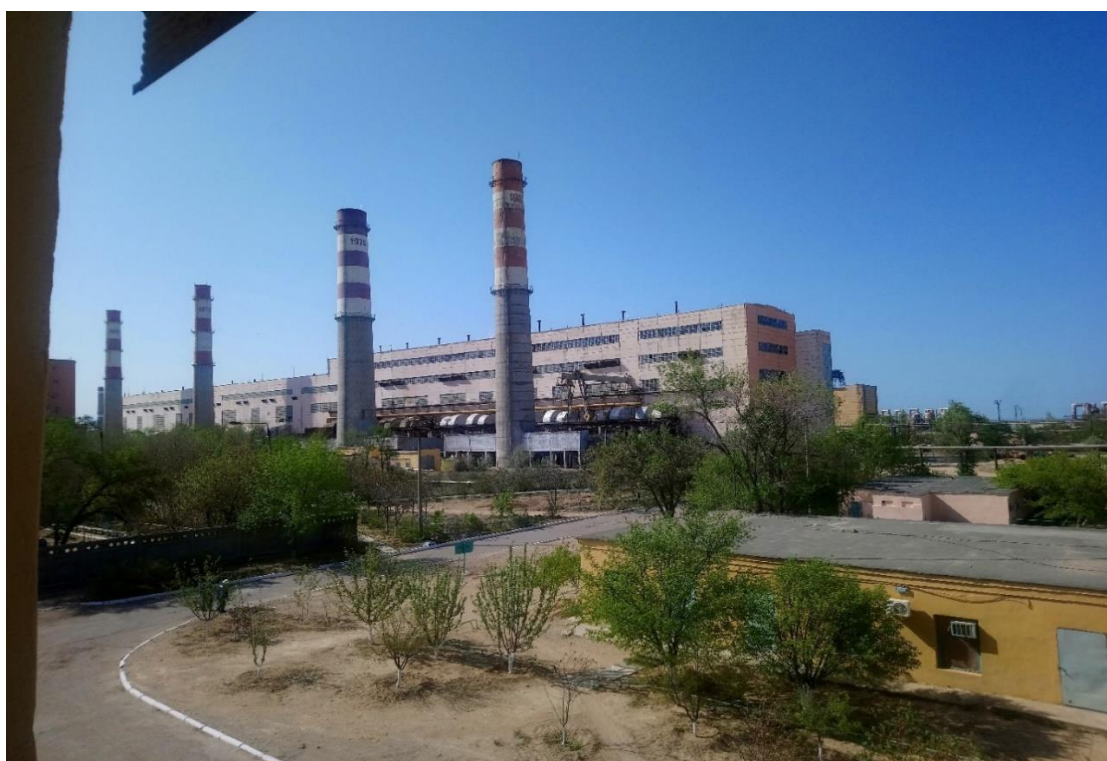
Фото 1. Общий вид ТОО «МАЗК Казатомпром» ТЭЦ-2
