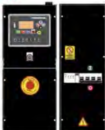
Панель управления ДГУ с автоматическим вводом резерва КОНТРОЛЛЕР SEA7
