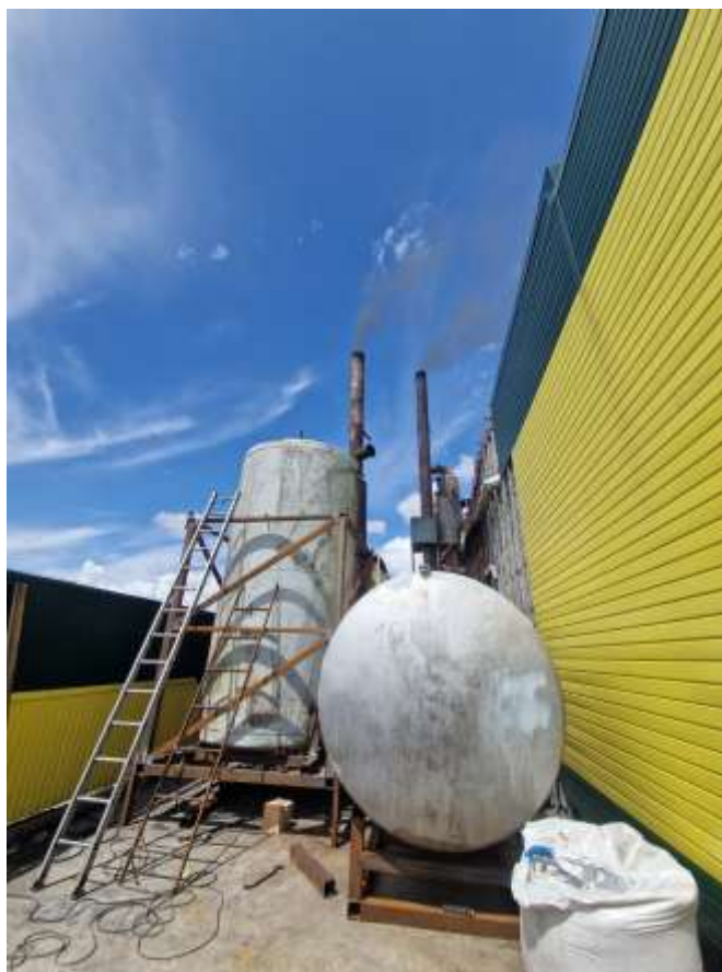
Фото 3. Емкости для щелочи, применяемой в мокрых фильтрах.
