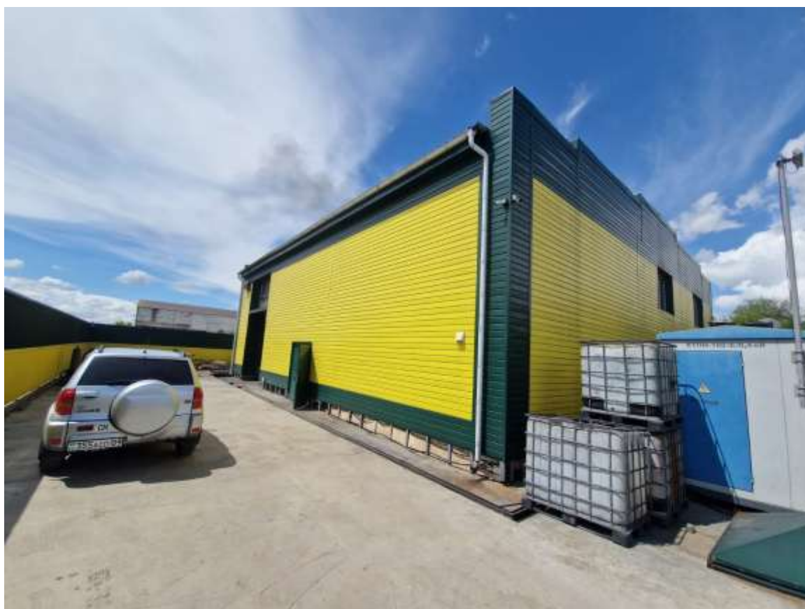
Фото 1. Здание цеха утилизации отходов с площадкой
