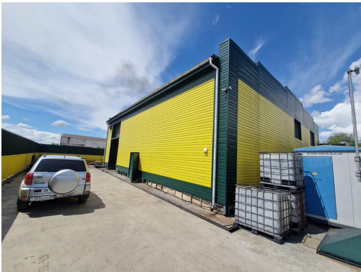
Фото 1. Здание цеха утилизации отходов с бетонированной площадкой
