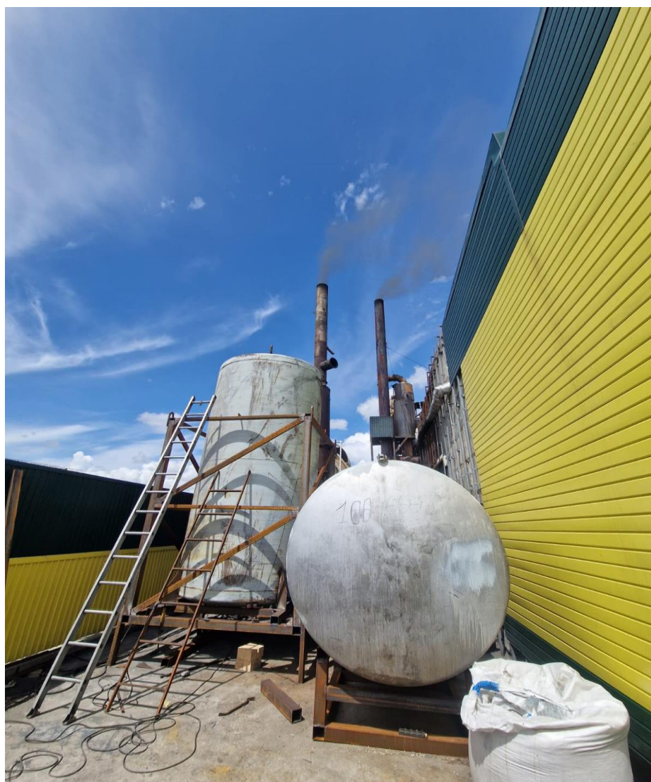
Фото 3. Емкости для щелочи, применяемой в мокрых фильтрах.
