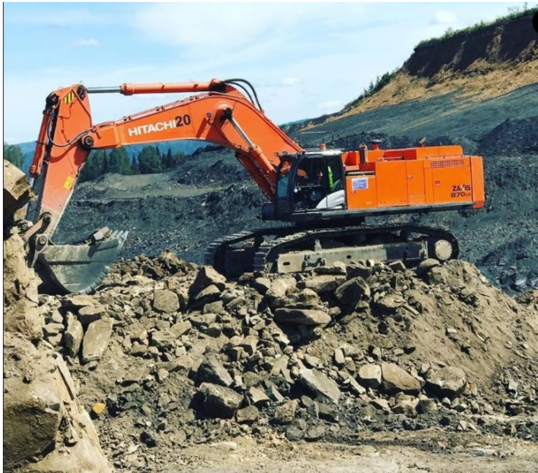
Рисунок 3.8 Гидравлический экскаватор Hitachi ZX870-5G с ковшом 4,5 м 3 .
