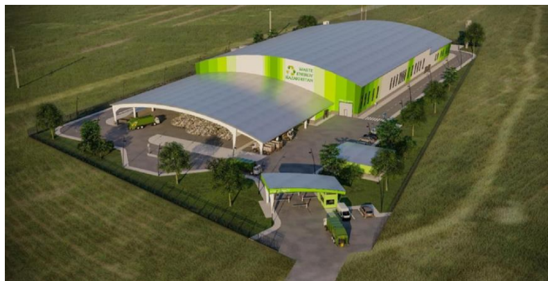
Рисунок 3 - Перерабатывающий завод полной утилизации ТБО
