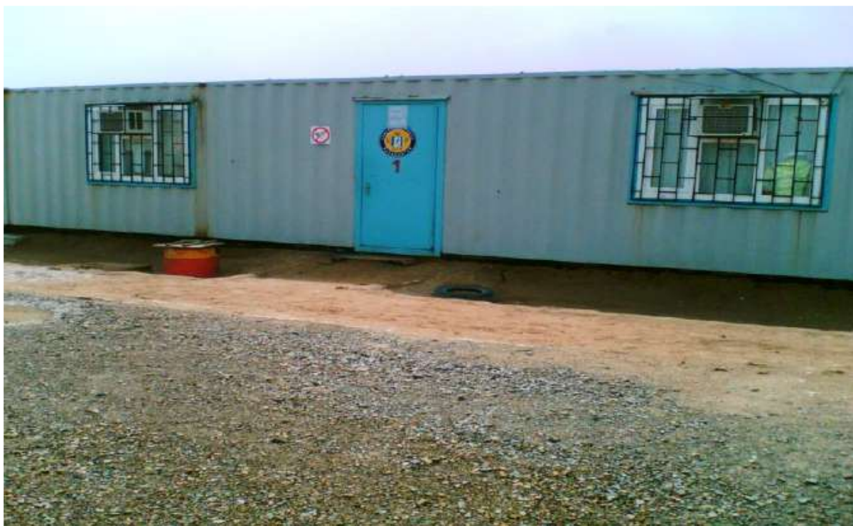
Рисунок 3.2-1 Производственный офис ТОО «Ком-Мунай»
