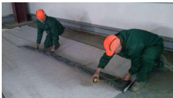
**Рисунок 1 - Разметка бентонитовых матов**
