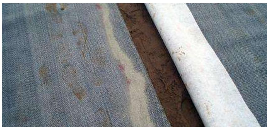
**Рисунок 2. – Способ укладки бентонитовых матов с герметизацией нахлеста бентогранулами**
