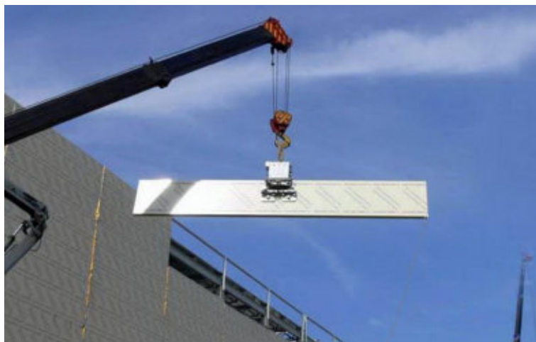
Рис. 9.8.2. Схема строповки сэндвич-панелей
