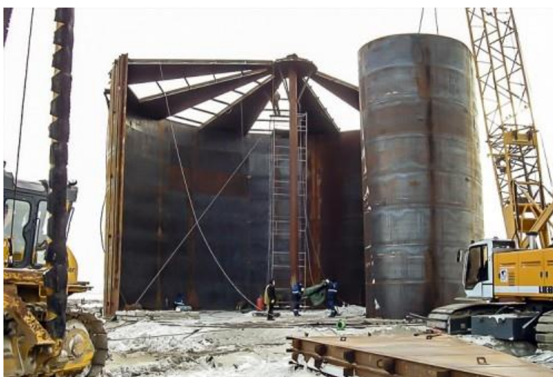
Рис. 9.3.1. Общий вид монтажа резервуара
