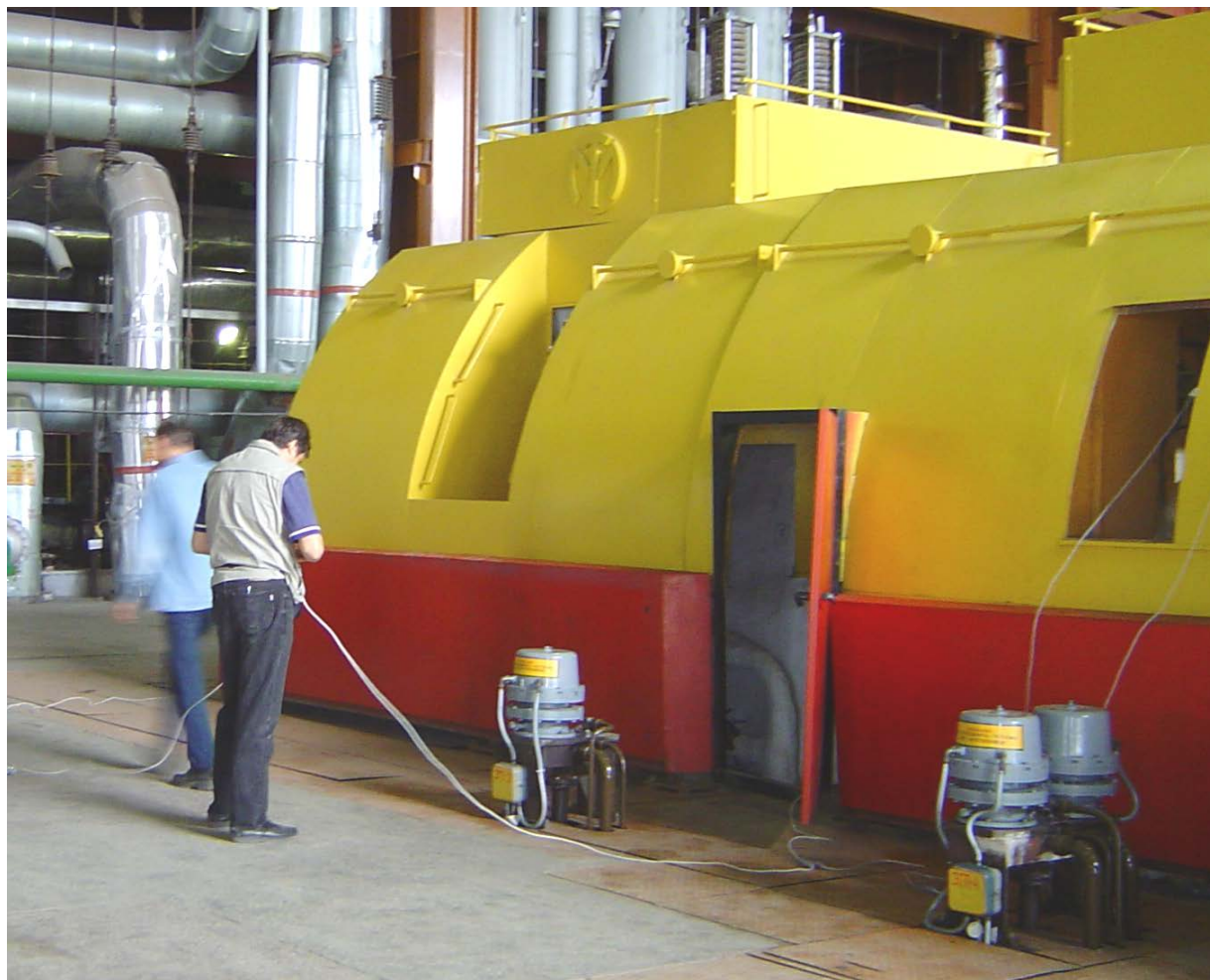
Рисунок 16. Блоки преобразования с установленными на них ЭГП, в процессе испытаний ЭГСР.
