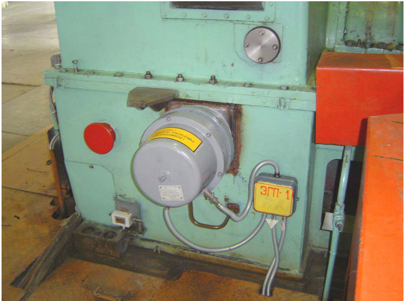
Рисунок 9. Установка ЭГП сервомотора ЧВД.
