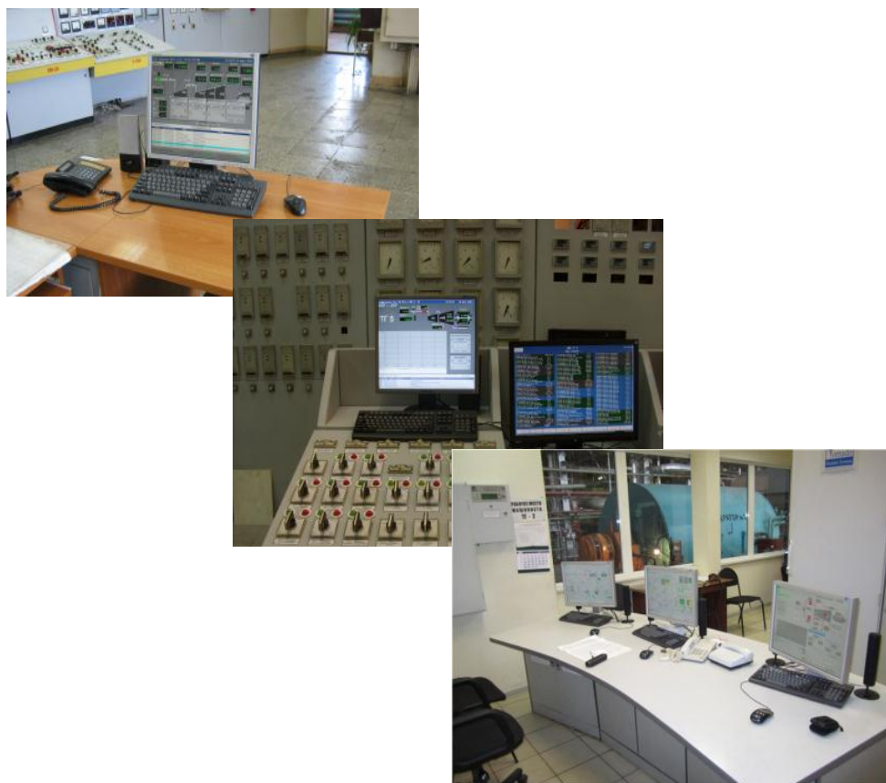
Рисунок 24. Примеры реализации автоматизированного рабочего места машиниста.
