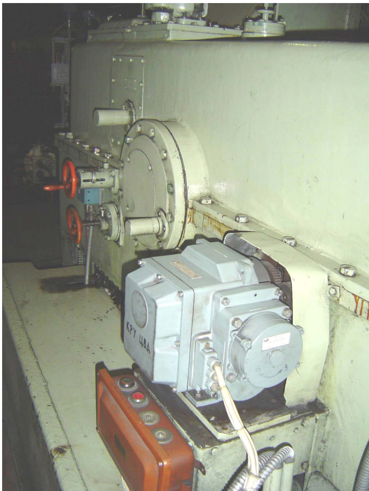
Рисунок 4. Привод золотника взведения на переднем стуле турбины.
