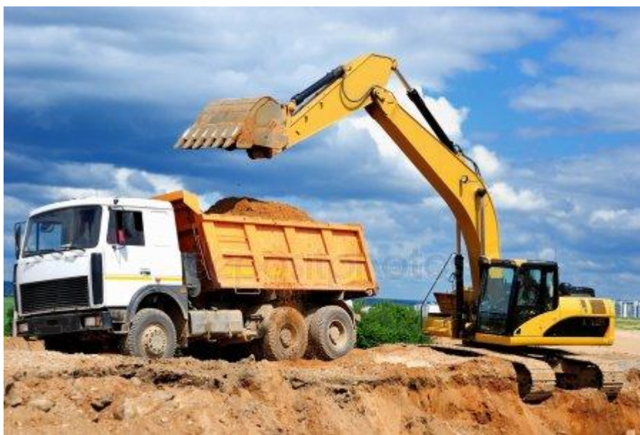
Рис 5.Погрузка ПРС
