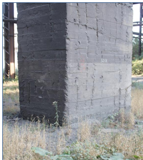
Рис. 8.2 Растительность в районе транспортной галереи
