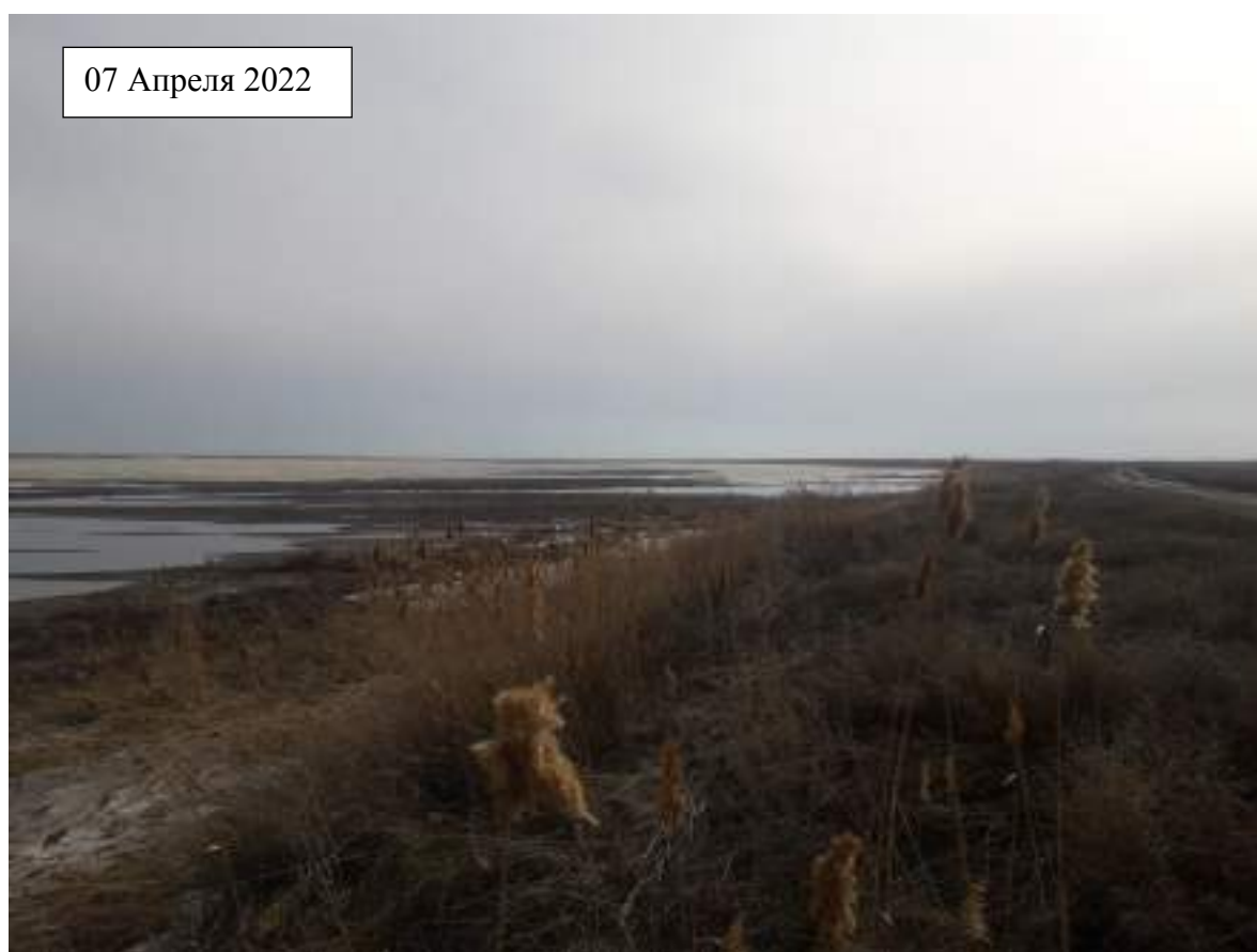
Рисунок 16 – Вид на ограждающую дамбу
