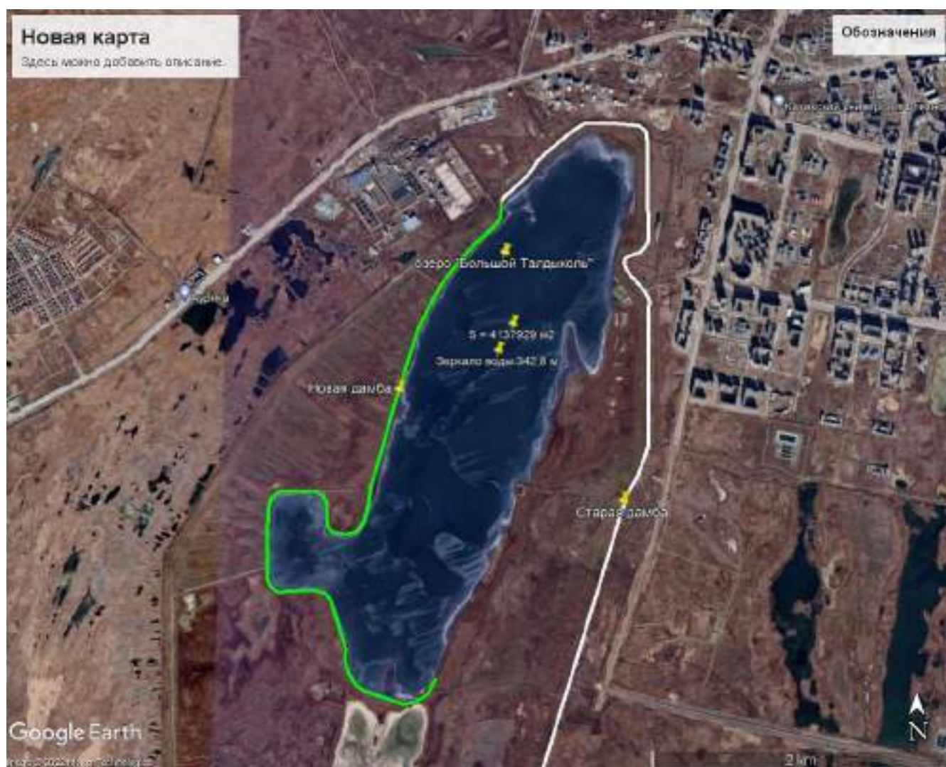
Рисунок.11. – Дамба обвалования накопителя Талдыколь - общий вид.
