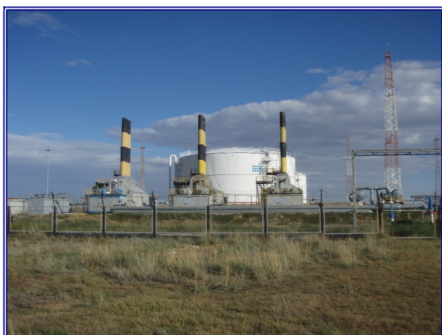
Рисунок 3.1.2-2 Печи подогрева нефти КНУ ВФ АО «КазТрансОйл»
