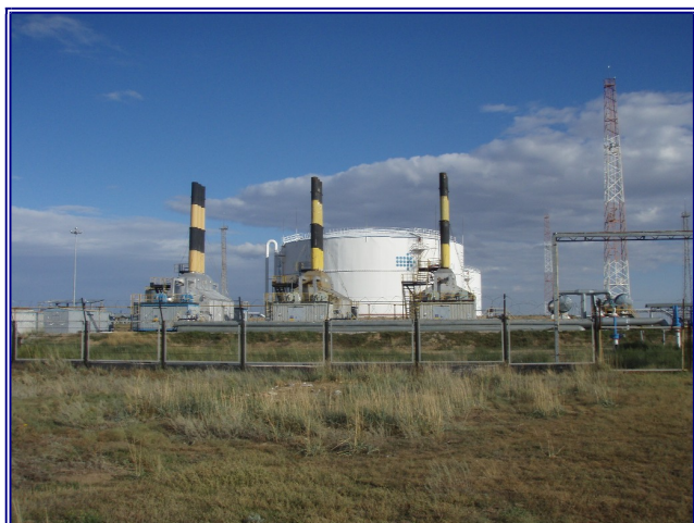
Рисунок 4.1.2-2 Печи подогрева нефти КНУ ВФ АО «КазТрансОйл»
