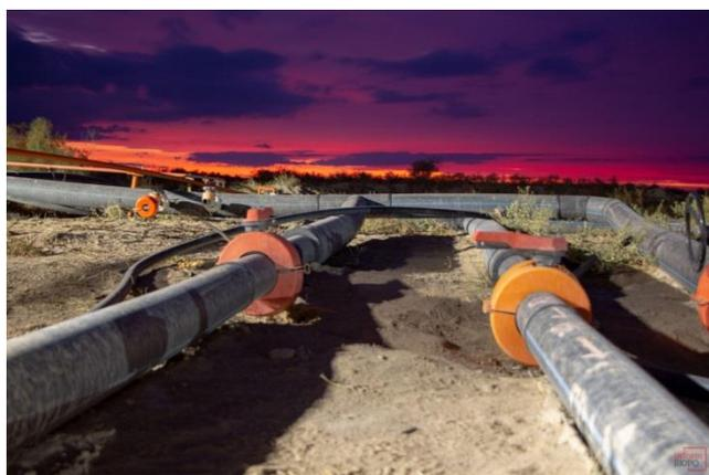
Рис.1.2.3 – Трубопроводы ПР и ВР без обваловки
