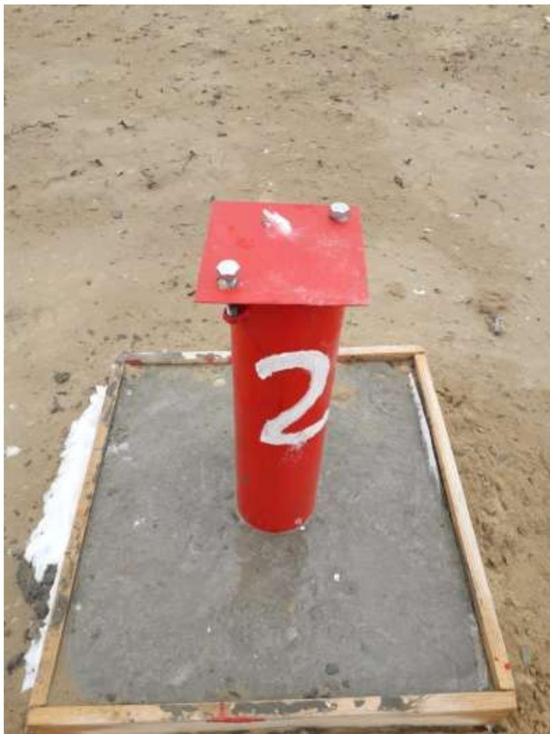
Диаметр наблюдательных скважин № 1Ф(фоновой) и № 2 составляет - 110 мм, глубина 5,3-5,7 м. метров. Фильтры - перфорированная труба с сетчатой обмоткой установлены в интервале 2,0-5,0 метров.
