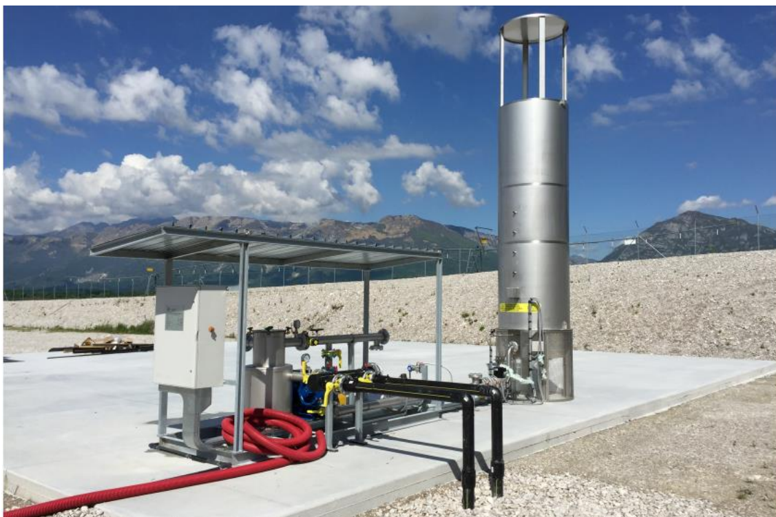
Рис.4. Общий станции для создания разрежения отбора конденсата и свеча для сжигания
