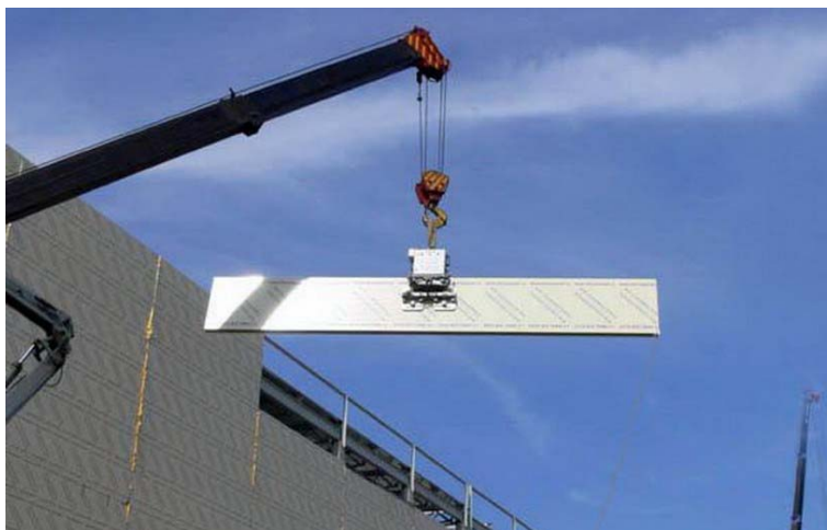
Рис. 5.9.2. Схема строповки сэндвич-панелей
