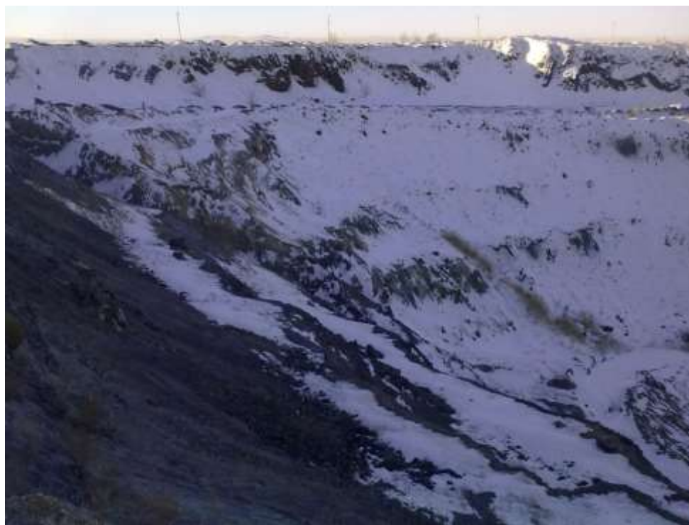
Рисунок 2 - Борт карьера в зоне предполагаемого расположения подъемника
