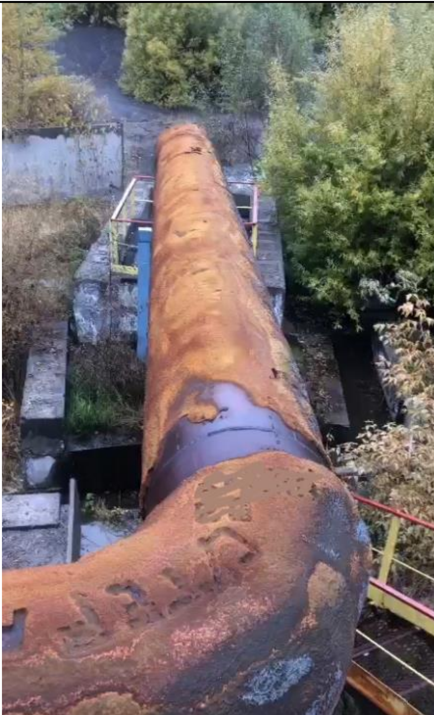
Рисунок 5.3. Трубопровод отвода очищенной сточной воды в ручей Безымянный после очистных сооружений № 7
