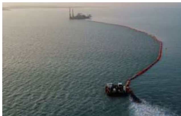
Рисунок 7.1 Собранный плавающий трубопровод, подсоединенный к дноуглубительному снаряду
