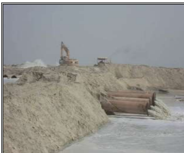
Рисунок 7.11 Шандоры и слив осветленной воды в море
