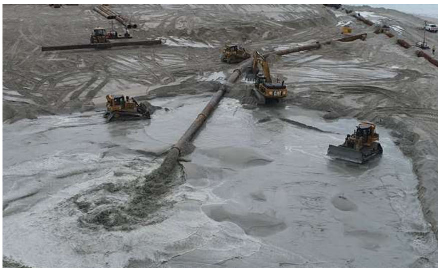
Рисунок 7.10 Расчистка пульпы, подготовка перемещения труб.
