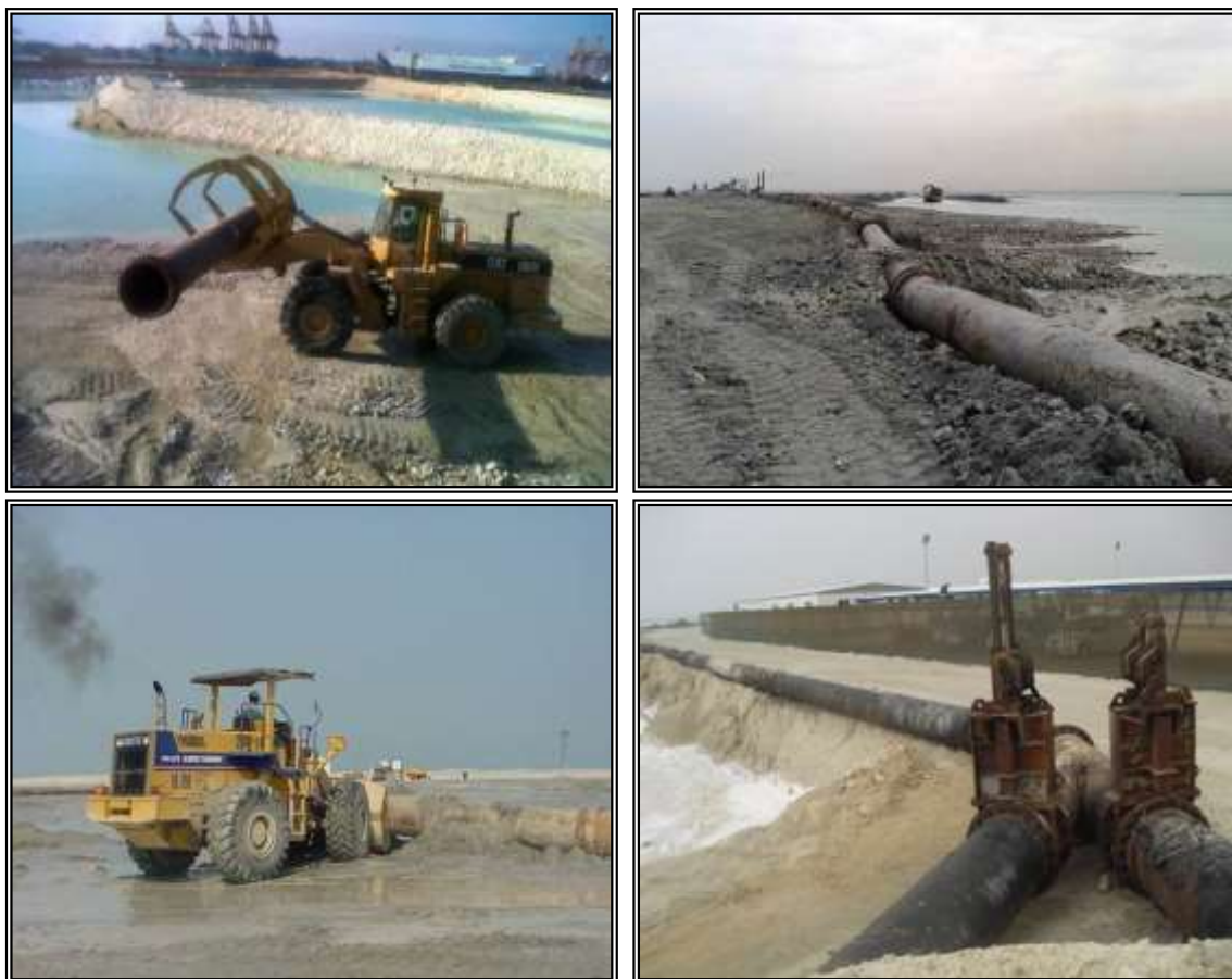
Рисунок 7.2 Прокладка берегового трубопровода
