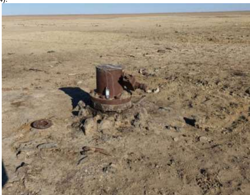
Рис. 4.3 Устье скважины Опорная-1А с застарелым переливом нефти
