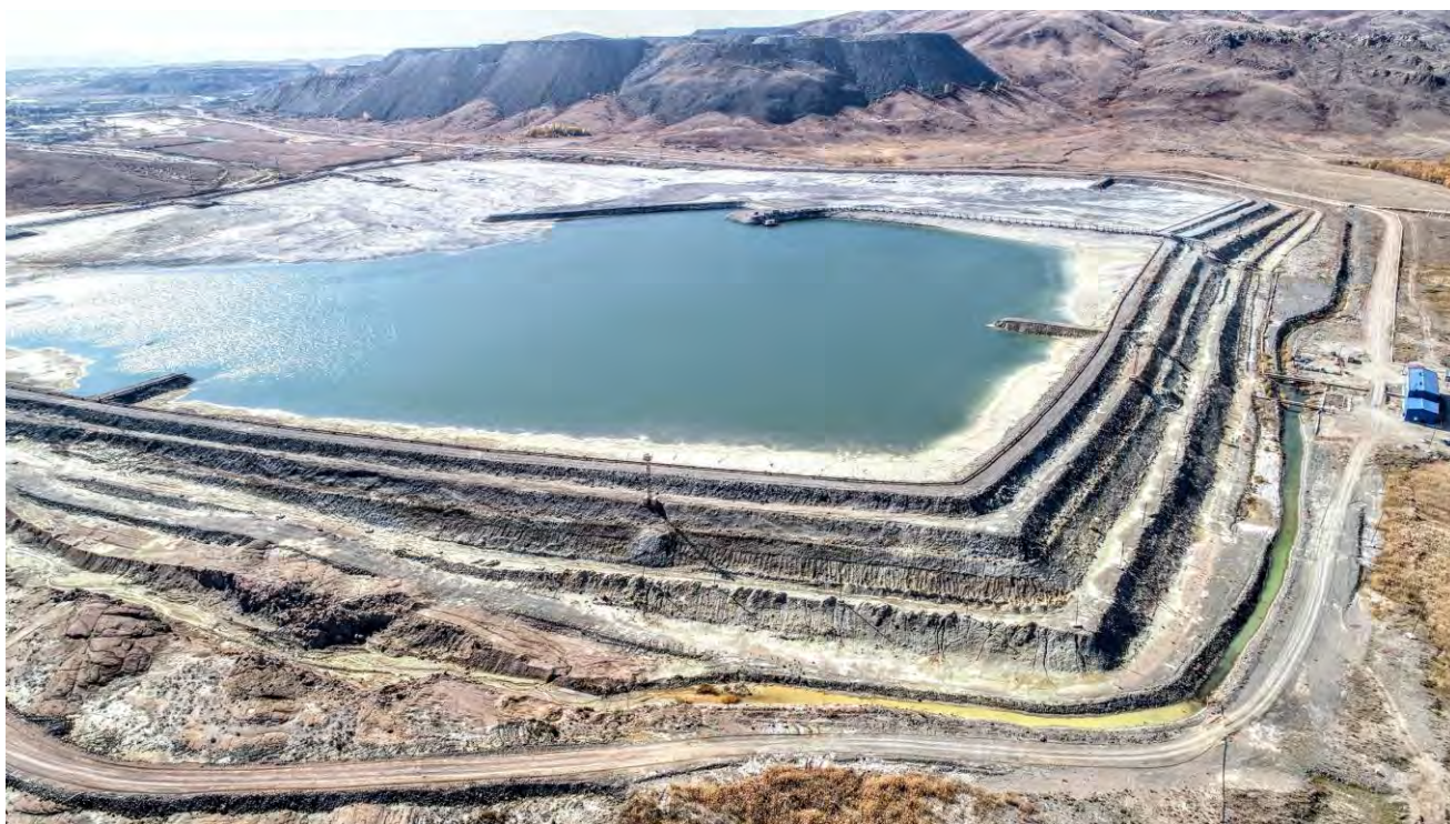
Фото 4.2.1 Отстойный пруд, пляжная зона, ограждающая дамба, дренажная канава, дорога, участки самозарастания по сост. на 11.09.2023 г.
