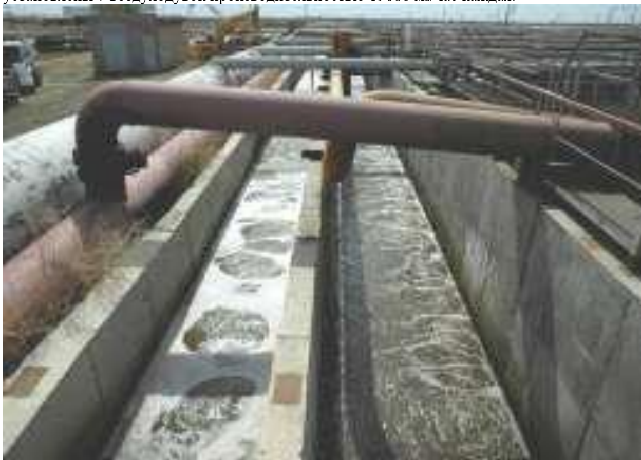
Рисунок 10 - Система подачи воздуха аэротенкам
