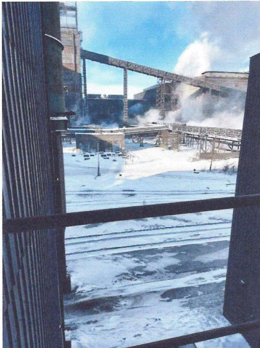
Рис.24. Вид на угол конвертерного цеха со стороны рукавных фильтров
