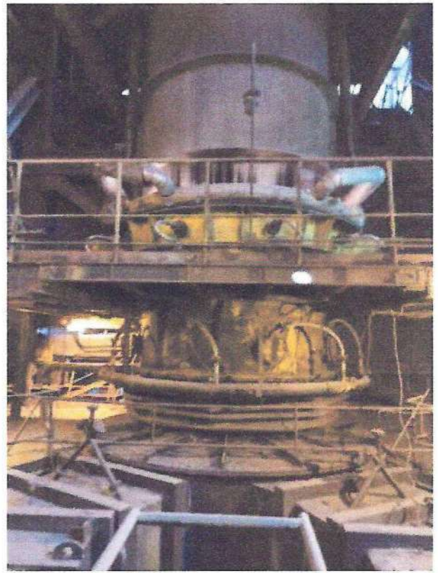
Рис. 16. Подвод орошающей воды к предскрубберу
