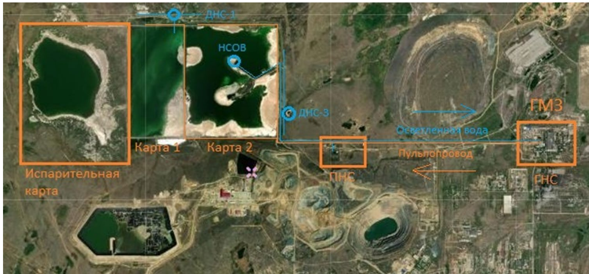
Рисунок 1.3.1 – Современное состояние хвостового хозяйства СГХК
