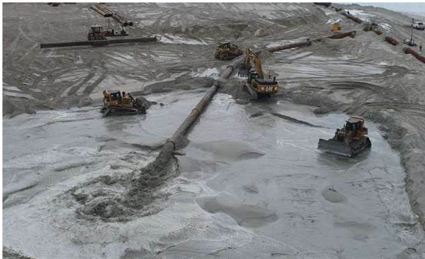
Рисунок 7.10 Расчистка пульпы, подготовка перемещения труб.
