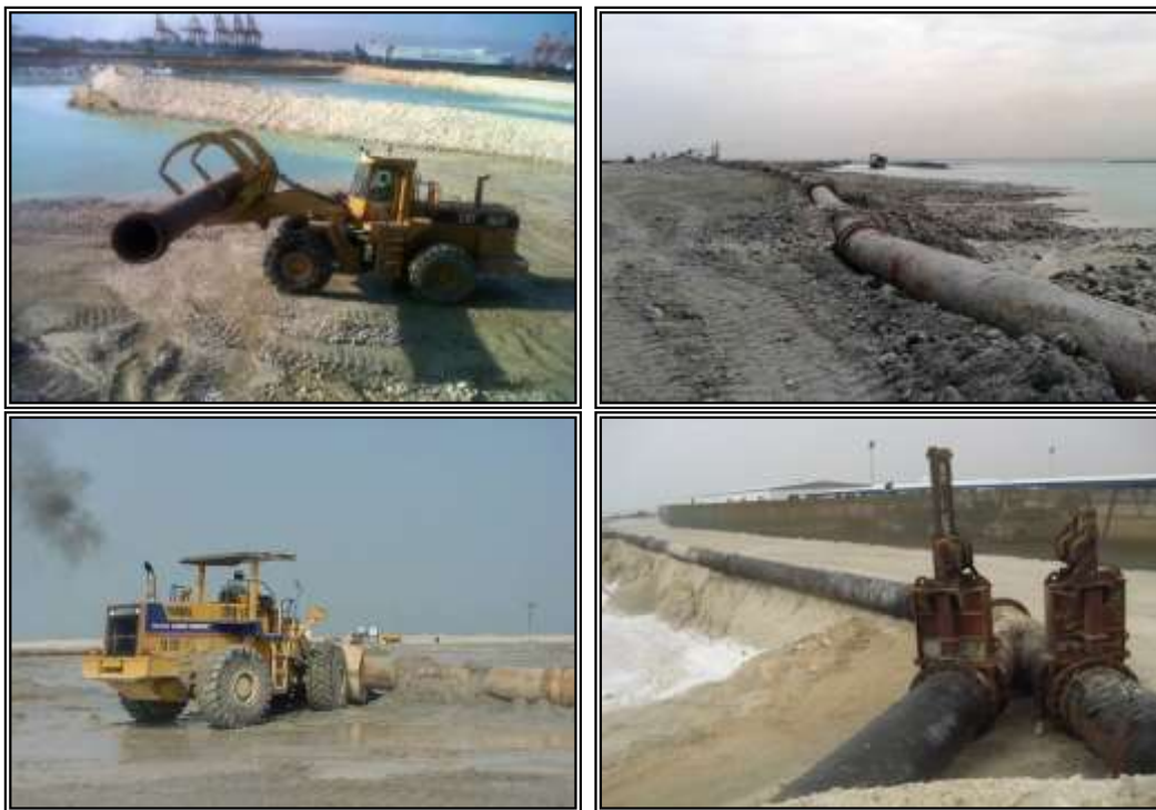
Рисунок 7.2 Прокладка берегового трубопровода
