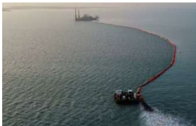
Рисунок 7.1 Собранный плавающий трубопровод, подсоединенный к дноуглубительному снаряду
