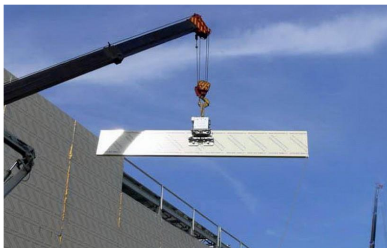
Рис. 9.7.3. Схема строповки панелей
