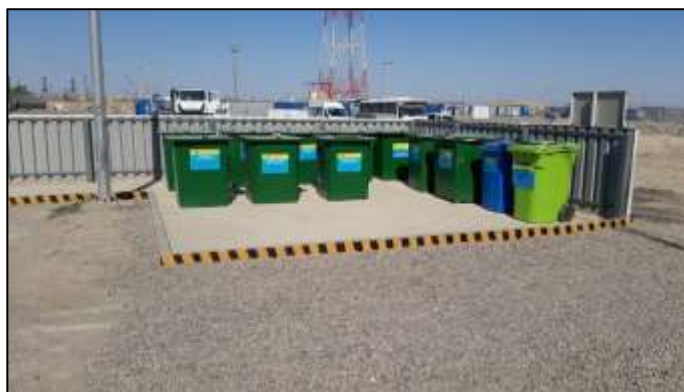
Рис. 2. Площадки для сбора производственных и бытовых отходов на НПС «Тенгиз»
