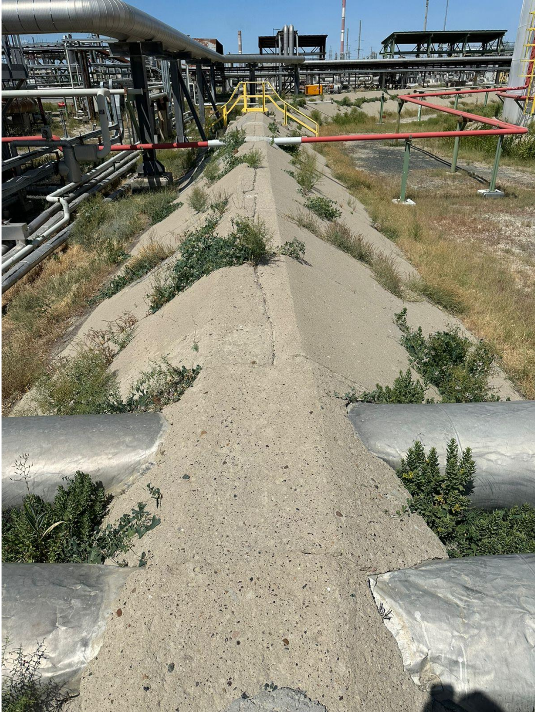
Рис.2. Бетонное обвалование вокруг резервуаров Т1-Т8
