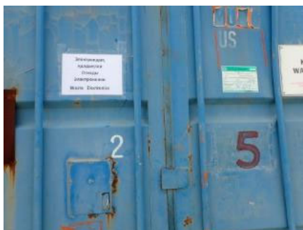
Фото 9 Площадка временного накопления отходов электроники на ТЭЦ
