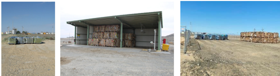
Фото 3 Площадка временного накопления отходов бумаги/картона, пластика на ТЭЦ
