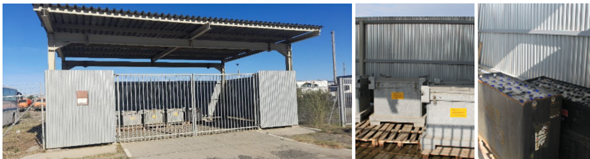
Фото 13 Площадка временного накопления для отработанных аккумуляторов на АРП
