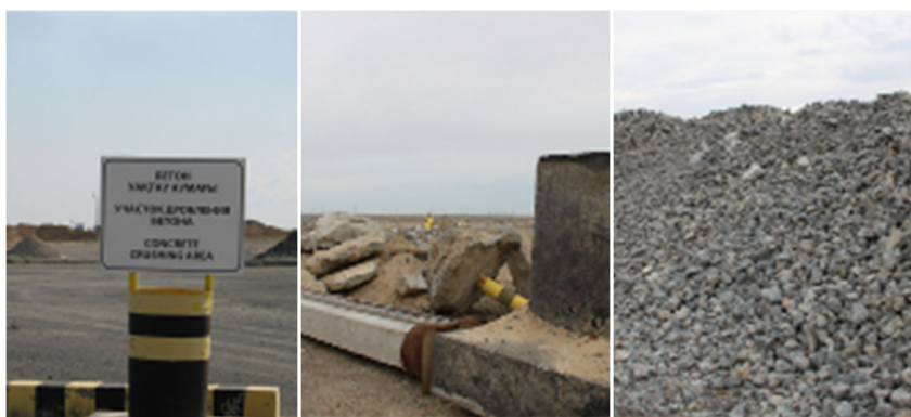
Фото 6 Площадка накопления бетона до и после крошения
