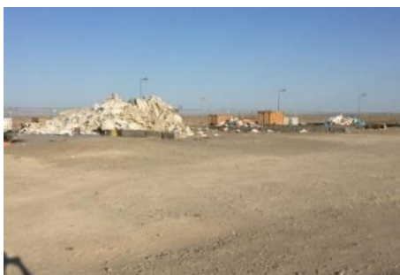
Фото 8 Площадка сортировки отходов строительства и демонтажа на ТЭЦ
