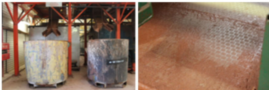
Фото 36 Процесс очистки бурового раствора на установках ENVIROCENTER
