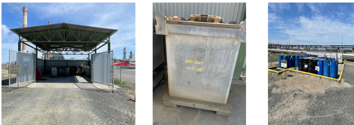
Фото 17 Площадка временного накопления жидких отходов химических материалов и отработанных масел на КТЛ (ХРХ)
