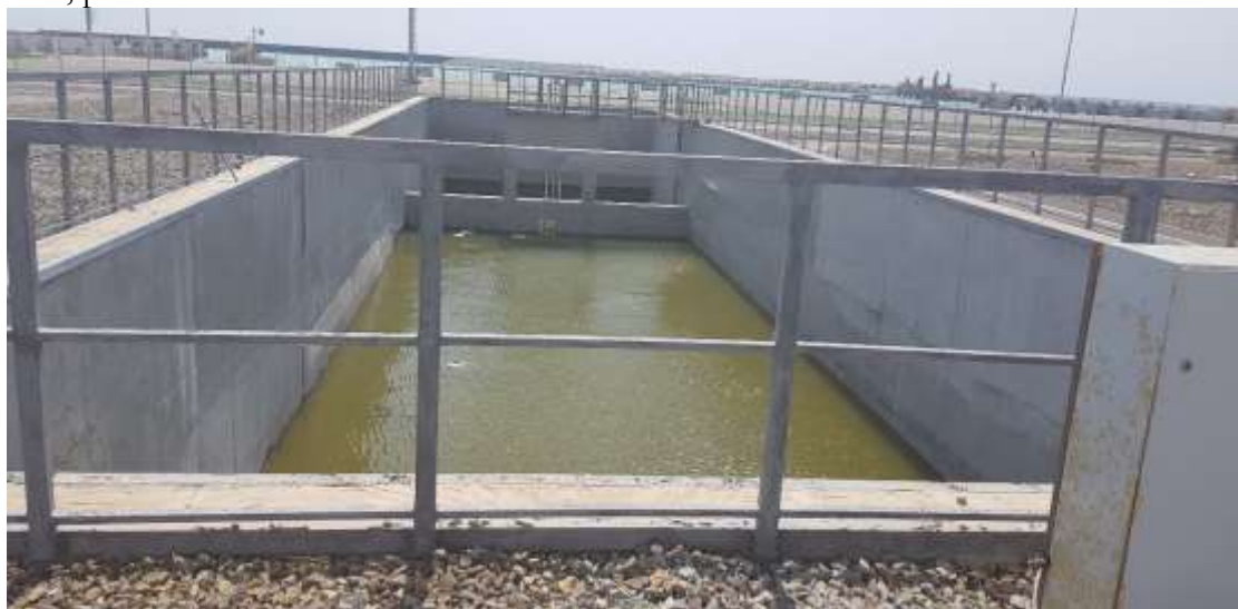
Рисунок 7.1.2.1.6 - Аккумулирующая емкость для дождевых стоков
