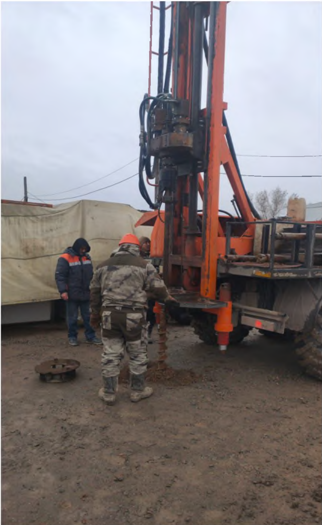
Процесс бурения инженерно-геологических скважин
